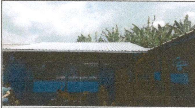
FOTO: 1 CUBIERTA DE LAMINA. Módulo 1 Aula 1
