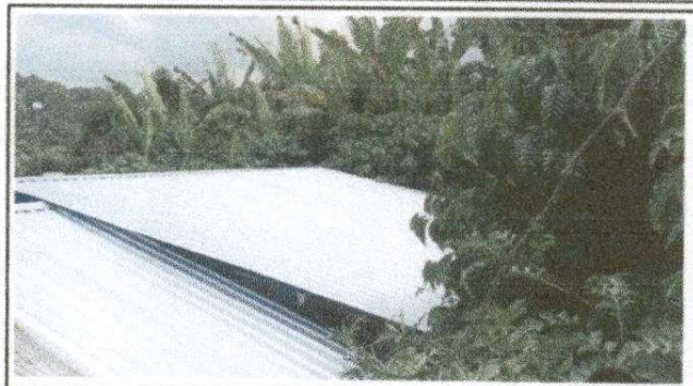
FOTO: 2 CUBIERTA DE LAMINA. Módulo 2 Aula 1
