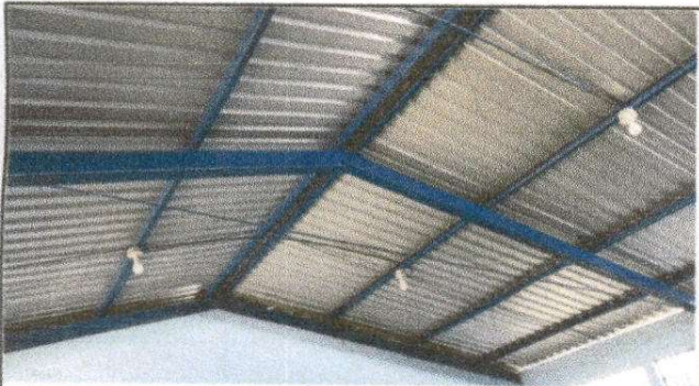
FOTO:3 REPARACION DEL SISTEMA ELECTRICO. Aula 1 Módulo 2
